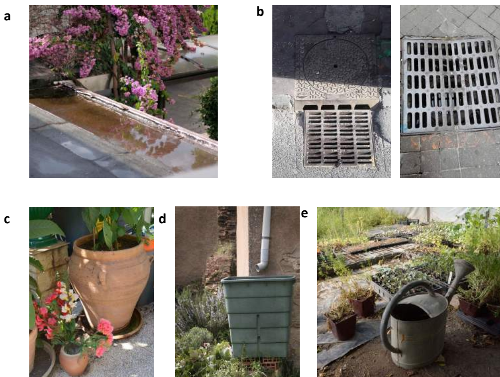
Photo 2. Différents lieux propices au développement d' Aedes aegypti et Aedes albopictus . (a) toiture terrasse favorisant la stagnation de l'eau, (b) avaloirs pluviaux, (c) soucoupes de pots de fleurs, (d) bidon de récupération d'eau de pluie, (e) divers récipients contenant de l'eau (e.g. arrosoir).
