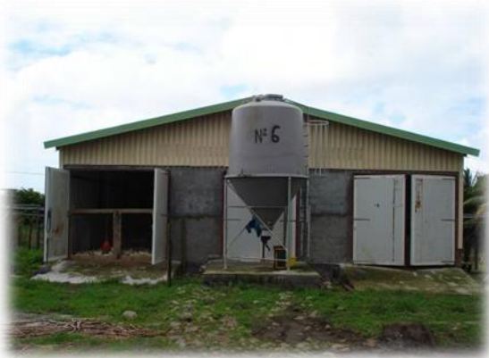
Figure 4 : Bâtiment de type « Péi », vue de l'extérieur (Henry 2011)
